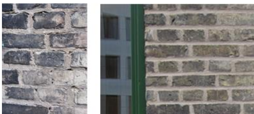
Exempel på befintliga fasadmateriäl i området (Semrén & Månsson)
