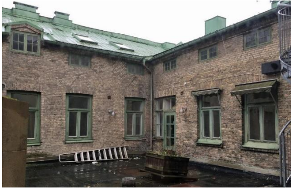
Gårdsmiljö vid Brogatan 2/Järntorgsgatan 4. Till vänster gårdshuset, till höger gårdsfasaden på Järntorgsgatan 4.
