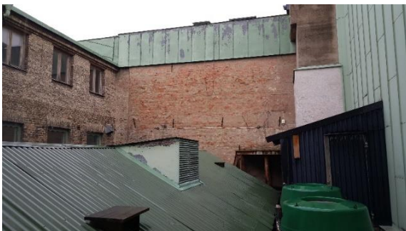
Befintligt gårdsrum Järntorgsgatan 6.
